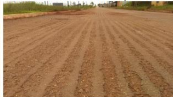
Figura 4 – Detalhe da ausência de mistura asfáltica nos locais onde ocorreu a falha na pintura
