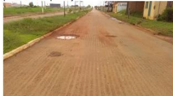
Figura 3 – Disposição longitudinal da falha na pintura de imprimação
