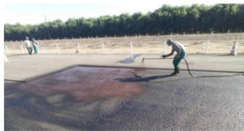
Figura 1 – Pintura manual de pista teste
