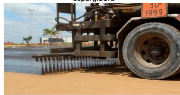
Figura 2 – Pintura mecanizada com barra espargidora
