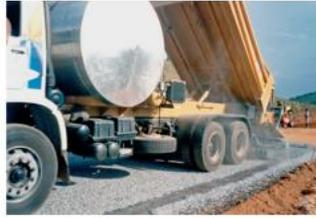
(a) Equipamento espargidor e distribuidor de agregados combinados
