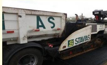
Caminhão conectado à vibro
