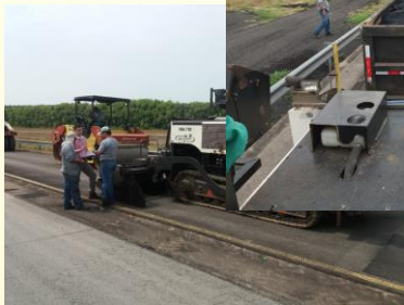
Posiciona-se a vibro acabadora no início de trecho
