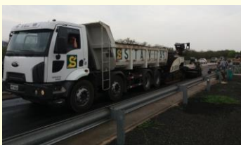
Caminhão sendo posicionado para descarregamento
