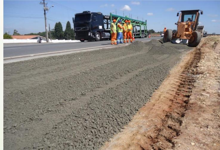
Por de definição brita graduada simples (BGS) é um material pétreo, oriundo da britagem de rocha sã e composto em usina, atendendo a uma distribuição granulométrica bem graduada e que quando compactada adequadamente resulta em uma camada de pavimento com propriedades satisfatórias quanto à estabilidade e durabilidade.
