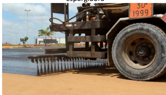
Figura 2 – Pintura mecanizada com barra espargidora
