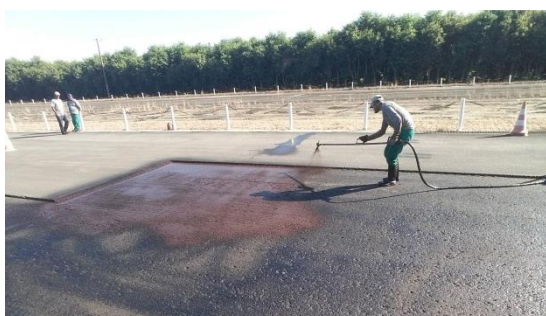
Figura 1 – Pintura manual de pista teste
