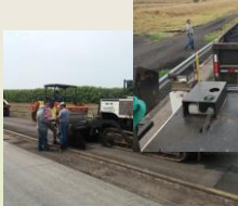
Posiciona-se a vibro acabadora no início de trecho
