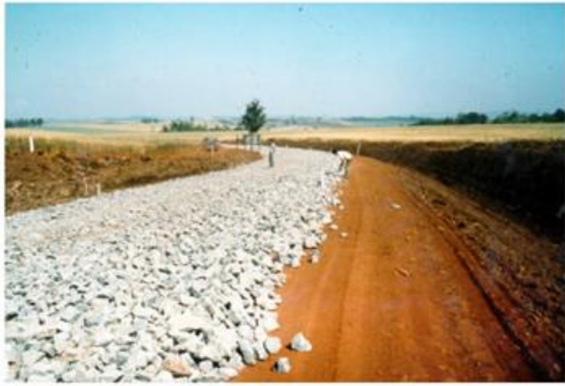
Figura 1 - Espalhamento da 1ª. camada de macadame seco.
