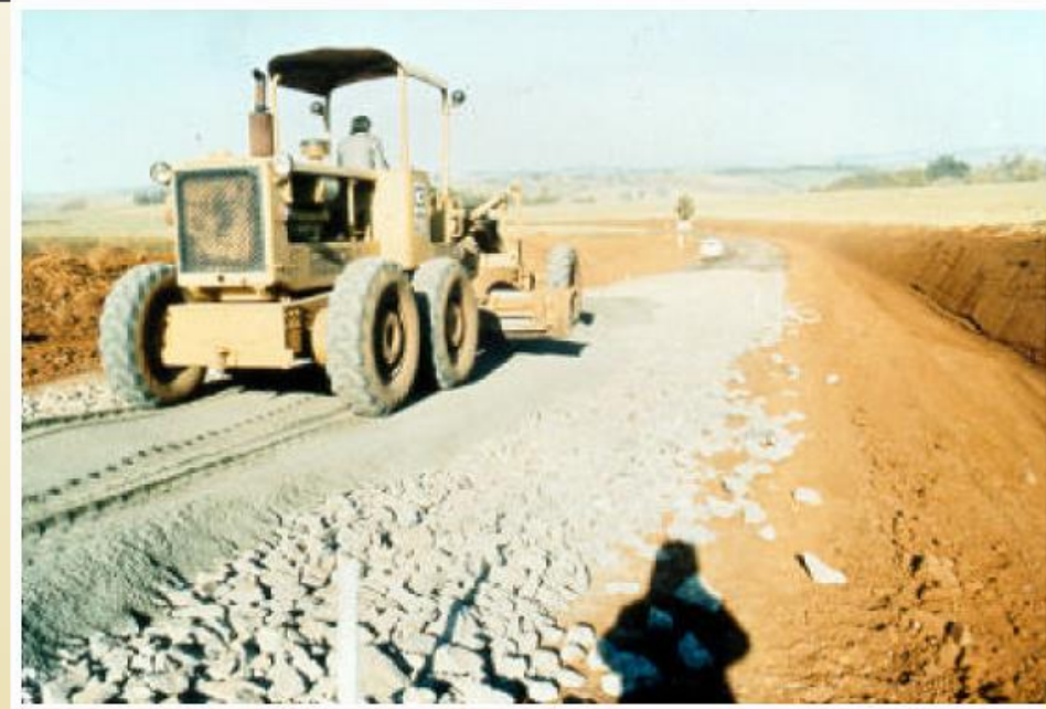
Figura 2 - Espalhamento da material de enchimento
