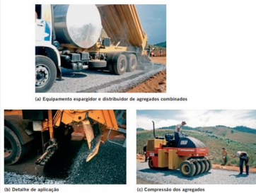
Figura 4.25 Exemplos de equipamentos e etapas construtivas de um tratamento superficial simples pelo sistema de equipamento especial com silos de agregado e ligante no mesmo veículo (Foto: Santos, 2003).
